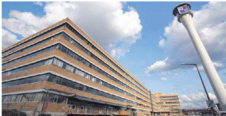
Geisterhaus in Nürnberg: das ehemalige Quelle-Versandzentrum FOTO: DPA
